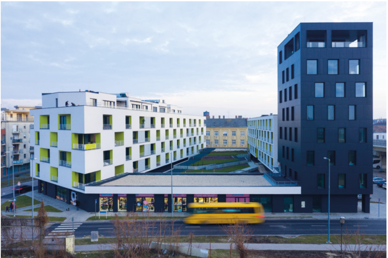
A két irányban teljesen nyitott épületegyüttes egy már meglévő háztól kölcsönzi hátsó homlokzatát
