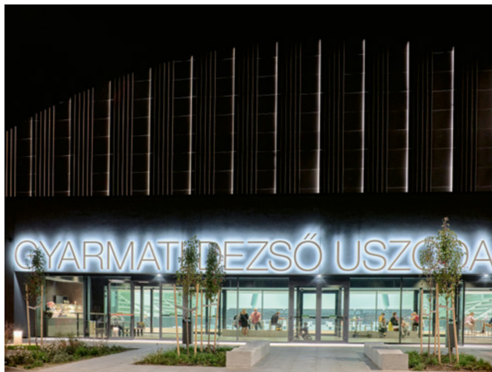
^ Esti fényben a déli homlokzat
