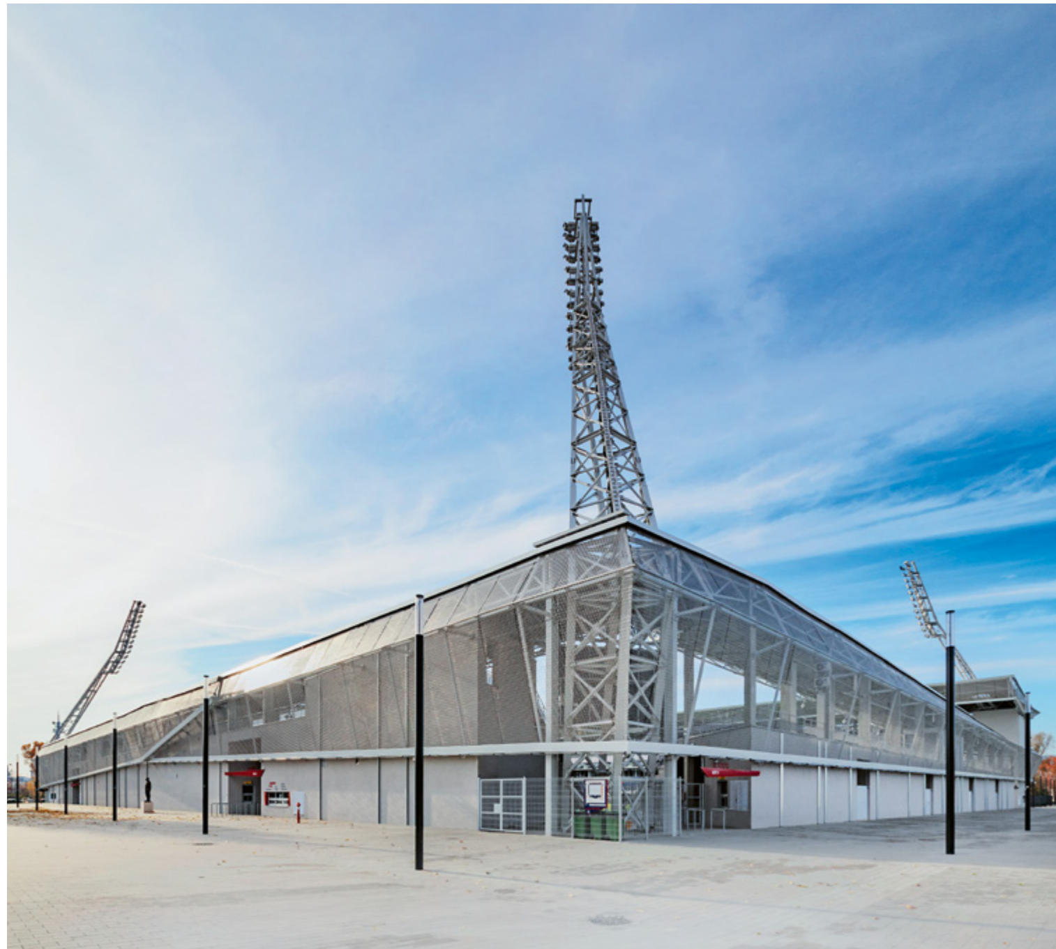
^ „A homlokzaton lévő acélszerkezet mintegy csontvázra ráfeszített acélháló az épület sarkainál, a hattyúnyak szerű lámpatartó oszlopok kitüremkedésénél lett megfeszítve.” (Kelemen Csaba felelős tervező)
