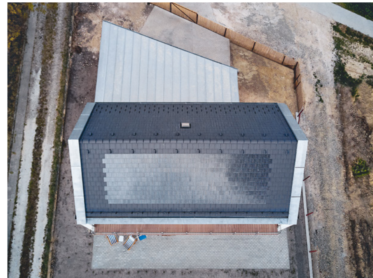
Igazán csak a telekszomszéd látja a házon lévő napelemes cserepeket
