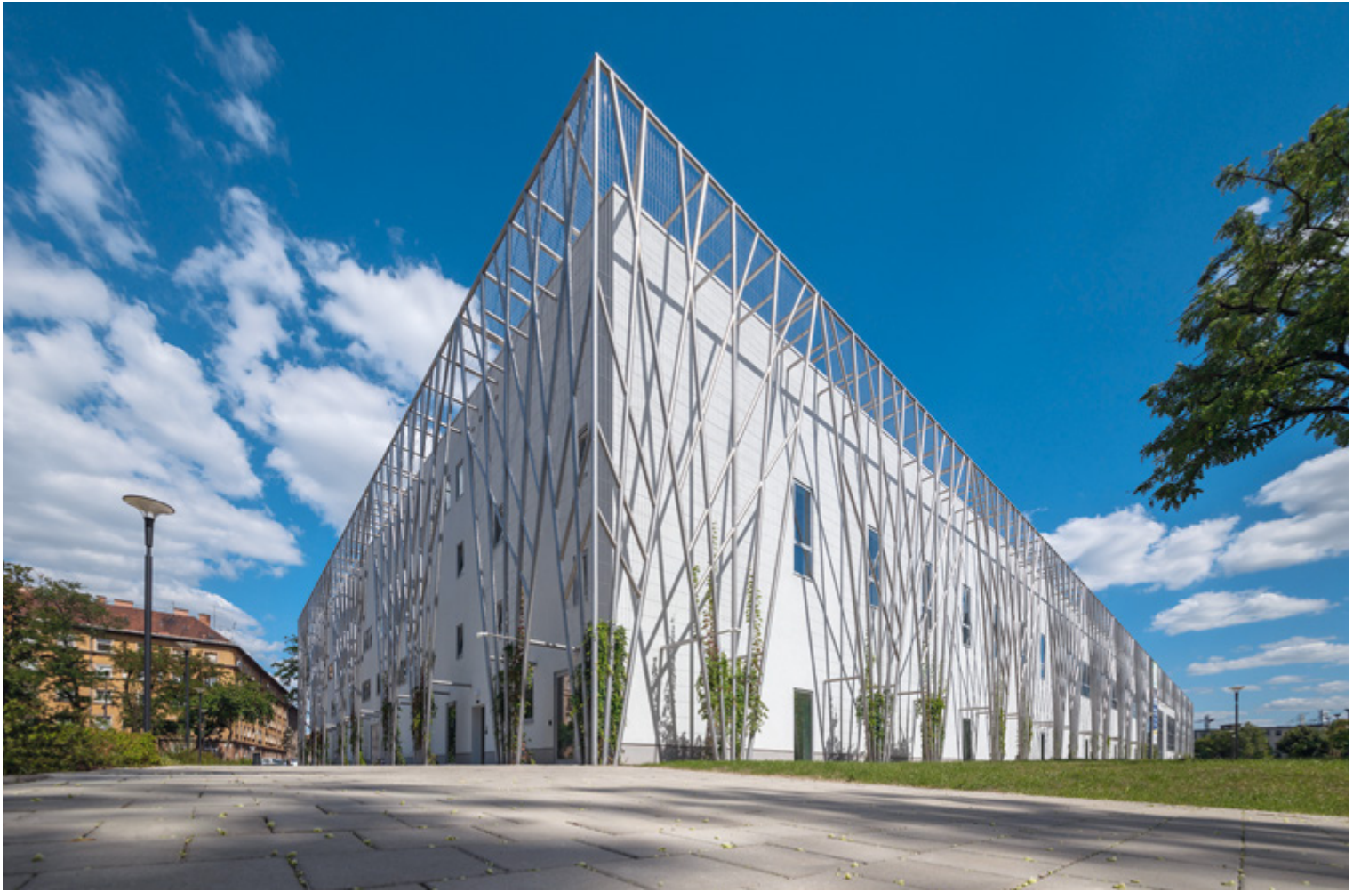
A Sportközpont második homlokzata, az eltartott, rozsdamentes acélszerkezetű rácszat.
