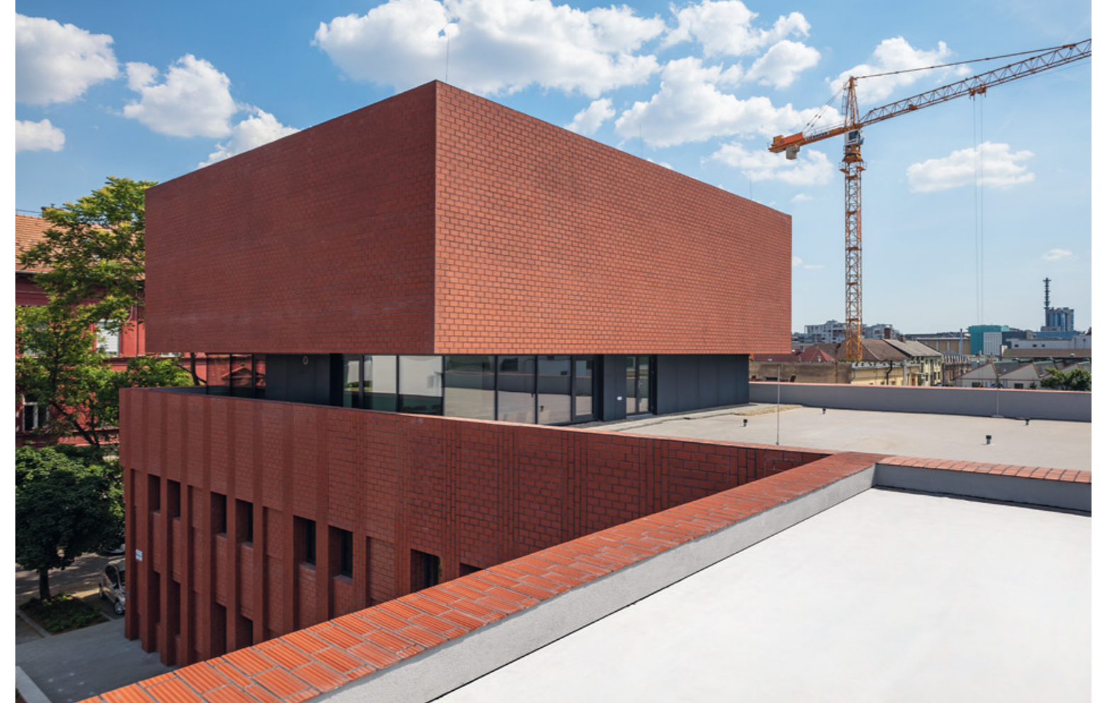
A kerület jellegzetes, tetején konzolosan kiemelt épülete.
