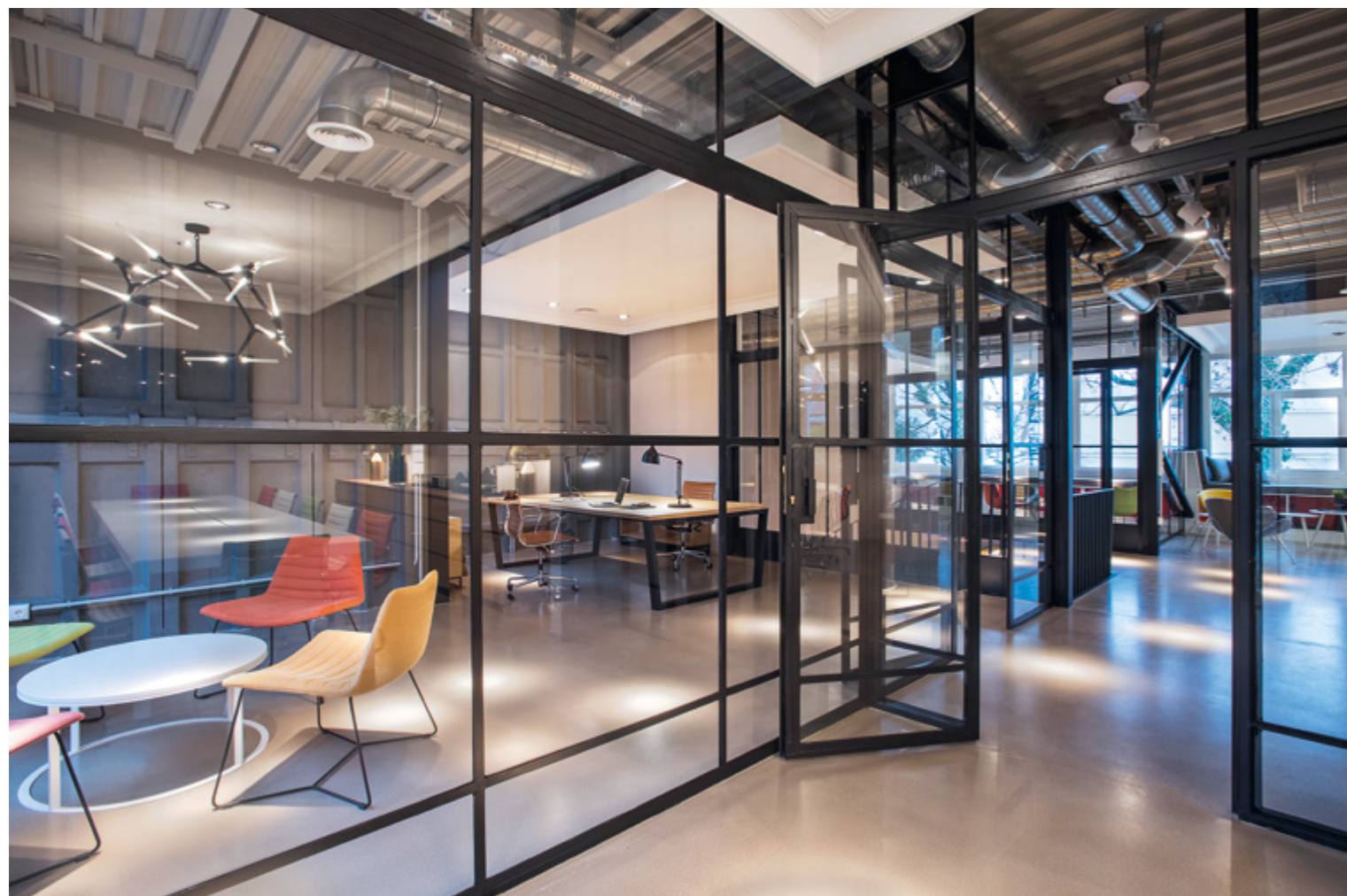
▼ Jórészt acélszerkezetes üvegfalak a térhatárolók.
