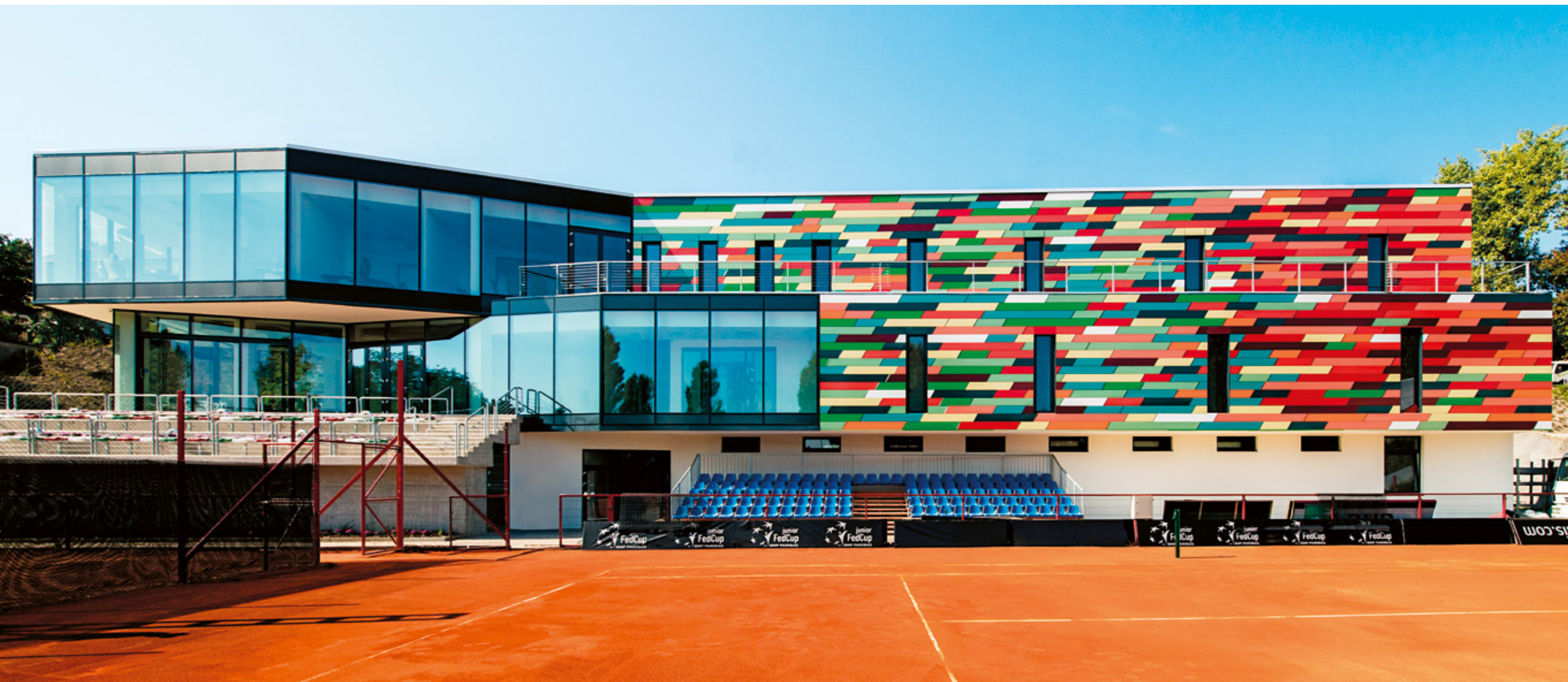
Tömör lamellás fémburkolatán 12 szín jelenik meg, de jellemzően a piros, a fehér és a zöld dominál
