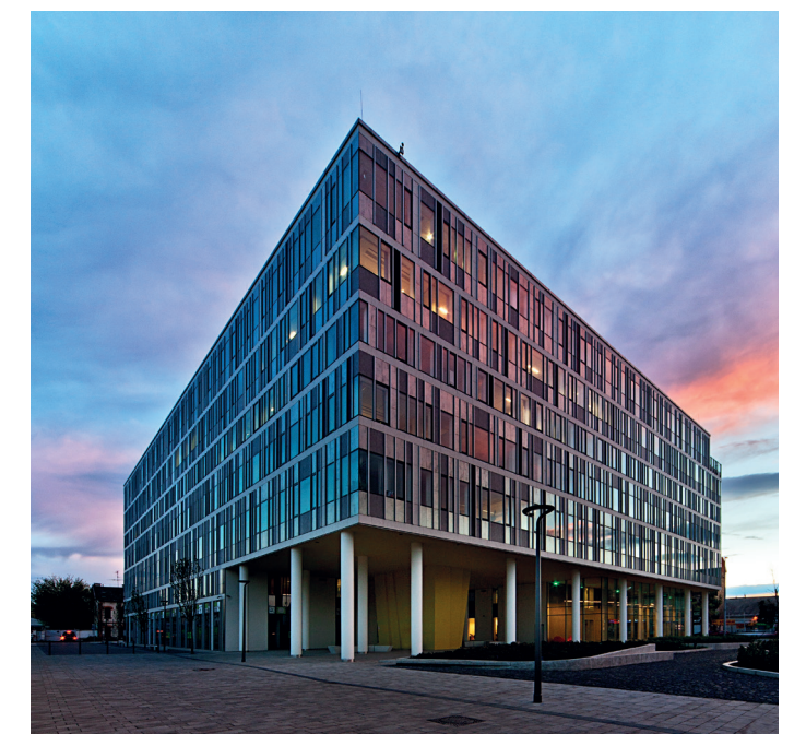
▼ Váci Greens irodaházak. Budapest; A épület; terv: 2008-; átadás: 2013
