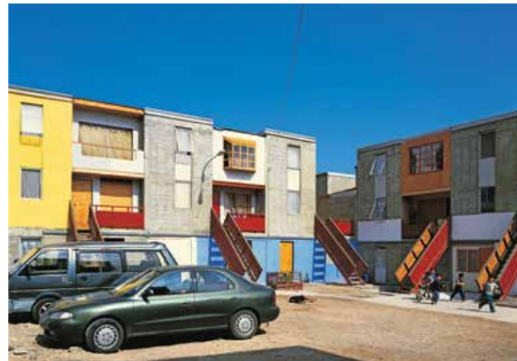
▲ Quinta Monroy lakásépítési projekt, Chile, építés: Alejandro Aravena; fotók: Cristobal Palma
