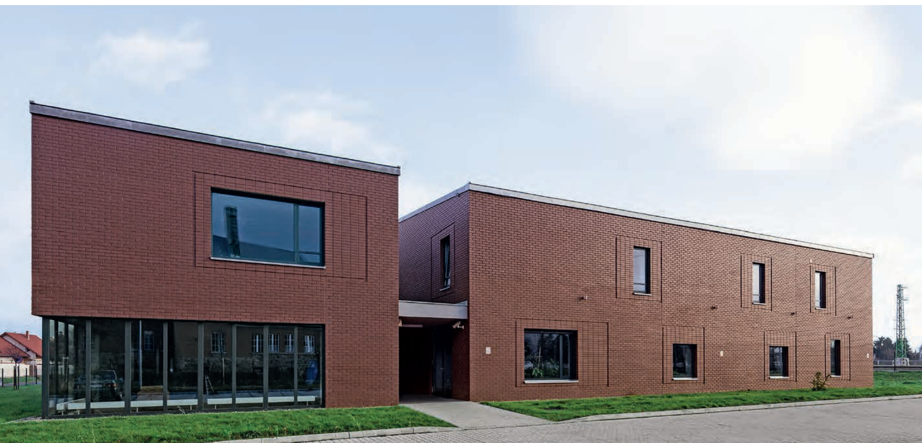
Időtálló zártság, masszív klinkertégla-homlokzatok
