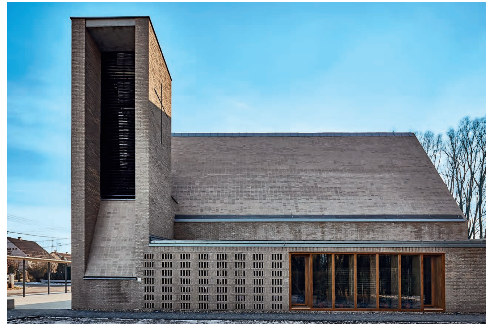
Az épület robosztusságát az átgondolt részletek és a jó kivitelezés egészítik ki
