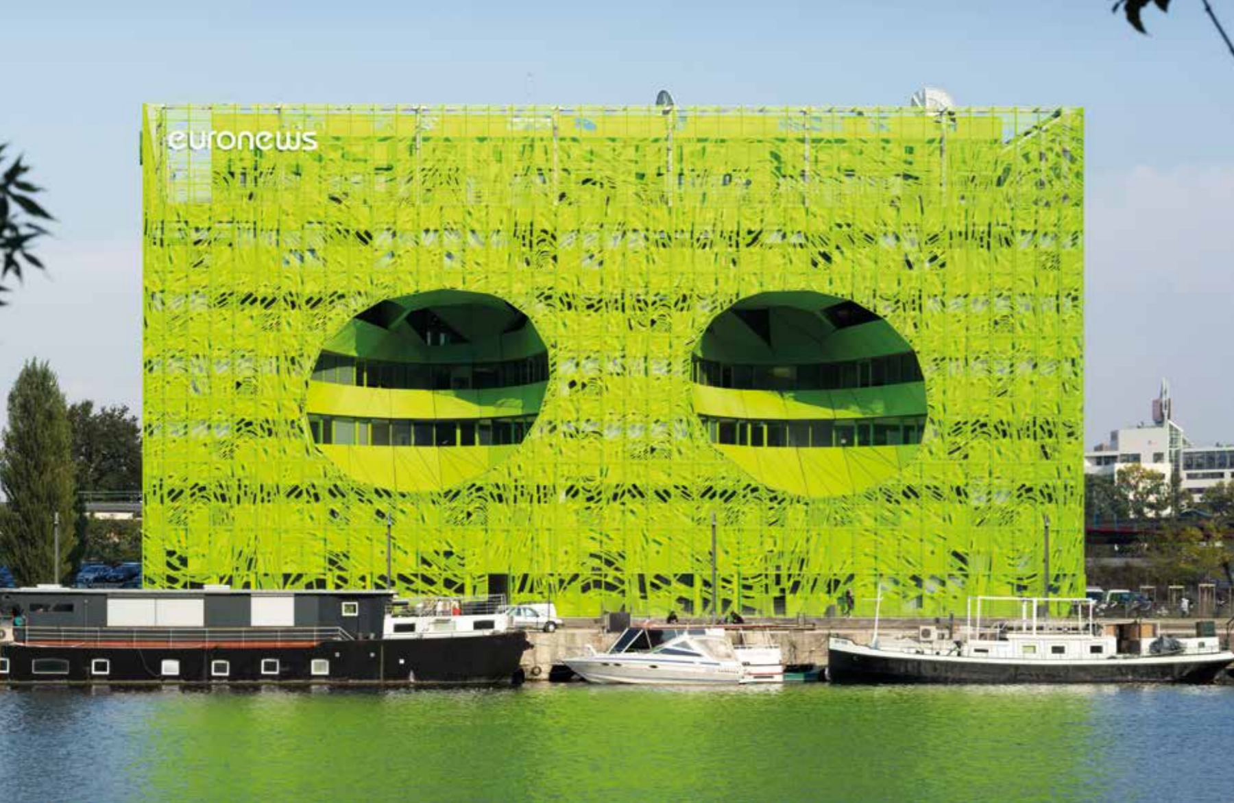
Az épület „két szeme” egy-egy tölcser, ami átfurakszik a kockán, összeköti az oldalát a tetejével, és ezzel bevezeti a fényt és a levegőt az épület közepébe
