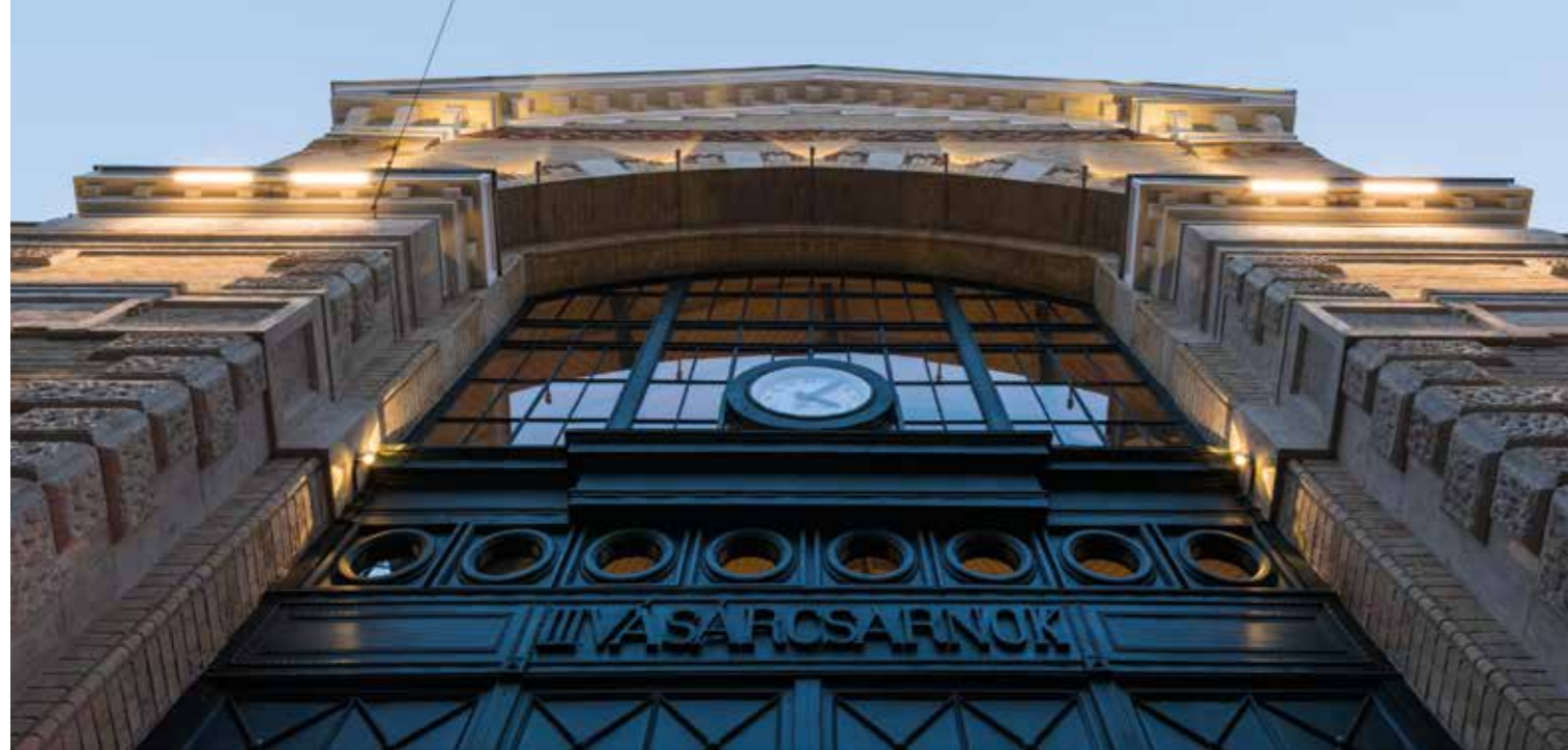
Renovált főbejárat rész
