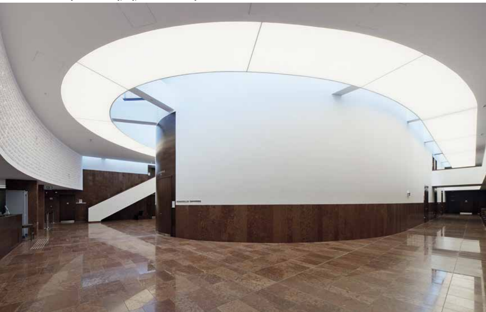
Tetőbevilágító-sáv övezi a nagy tárgyalót a földszinti közforgalmi térben
