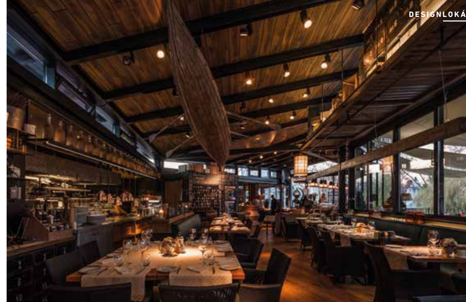
Látszó szerkezetek – HEA-gerendák és csavarok – és a ridegségüket oldó tölggyfa burkolatok (Fotó: Batár Zsolt)
