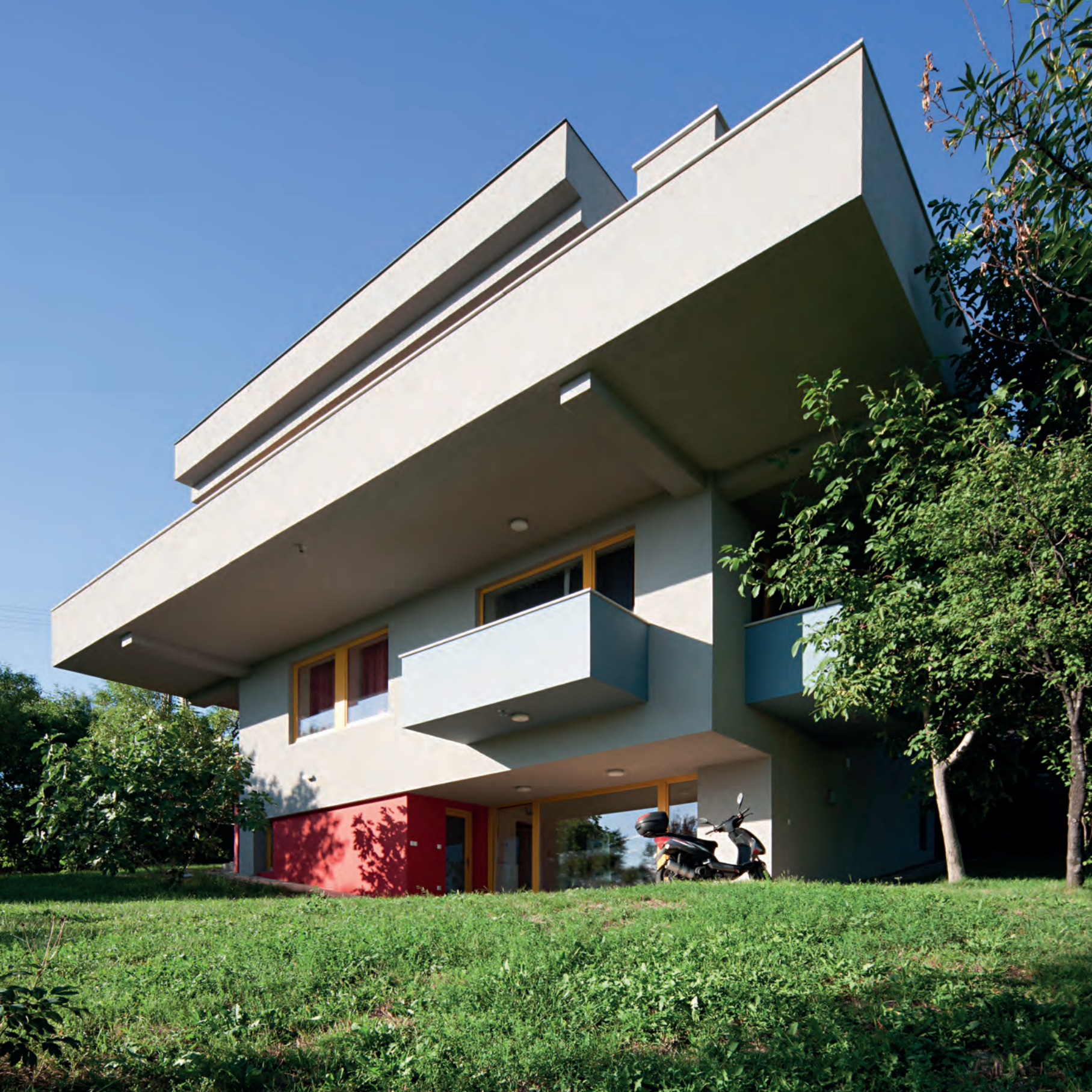
A közvetlen kertkapcsolatot megteremtő földszinti megnyitás igen visszafogott, visszahúzott helyzetbe került
