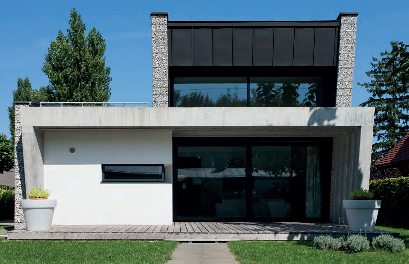
A nyaraló-lakóház a legkorszerűbb gépészeti rendszerrel lett felszerelve
