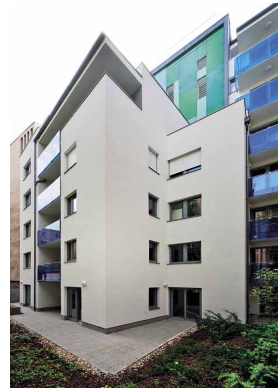
Színes üveg parapetek gazdagítják a kertre néző homlokzat tványát. A szigetelést a Caparol Hungária Kft. Capatect homlokzati hőszigetelő rendszerével végezték
