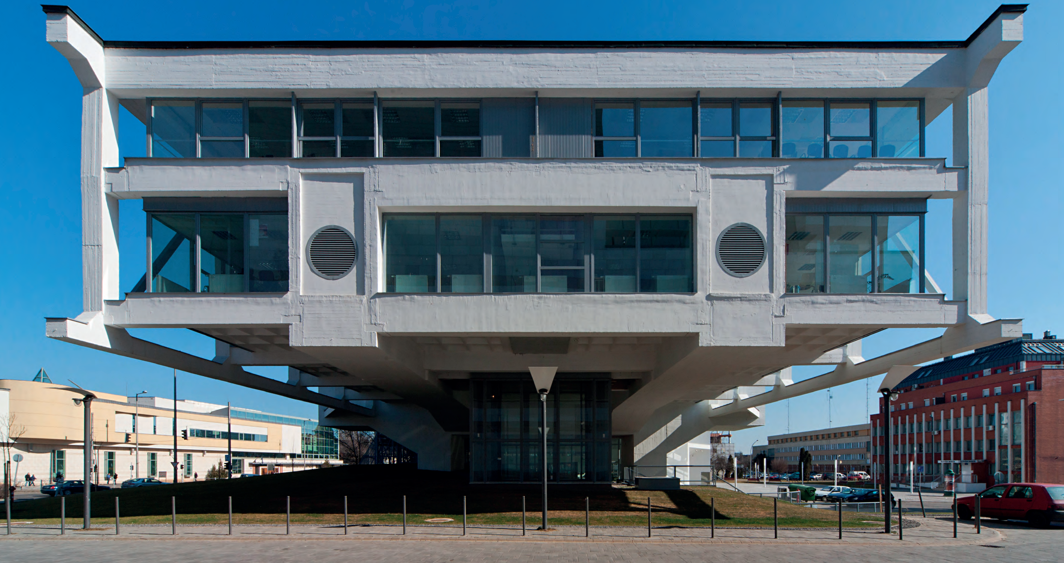
Tisztán olvasható a szerkezeti rendszer, nem minden eleme helyszínen zsaluzott és öntött
