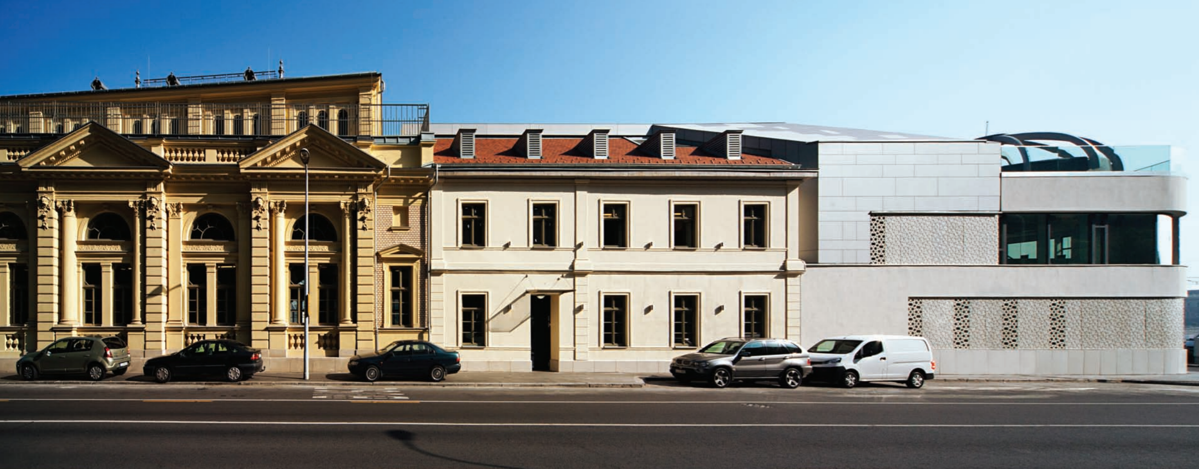
Az uszodacsarnok, az étterem és a wellness-szárny Gellérthegy felőli homlokzatai
