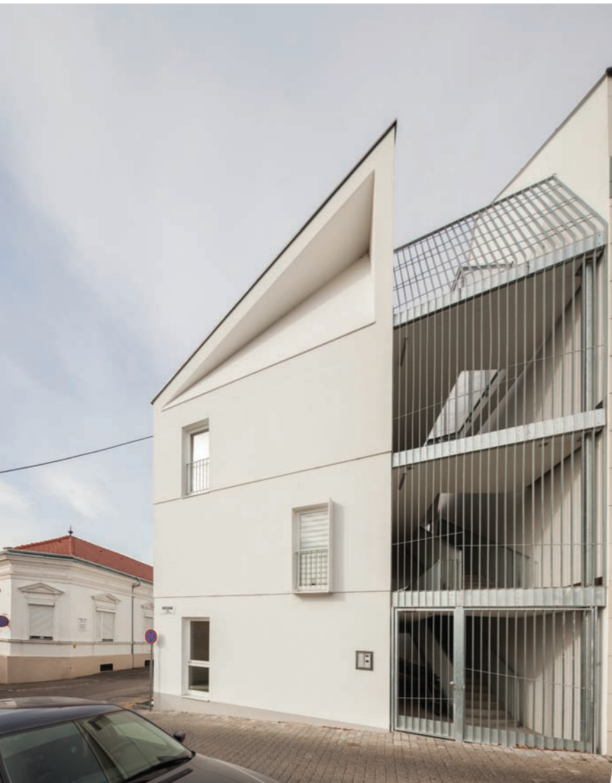
Tervezője a szomszédos épülethez egyszerű, horganyzott acélrács felülettel kapcsolja a homlokzatot
