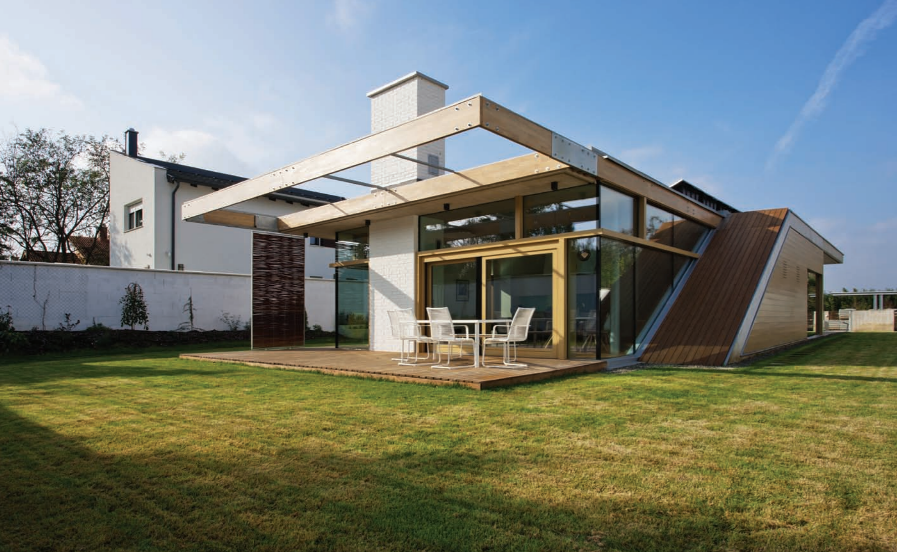
A terasz fölül jellegzetesen kifutó tetősík nyáron árnyékoló ponyvát tart. A ház oldalában látható, fával fedett idom egy majdani emeletrépitésnél lépcsőként szolgálhat
