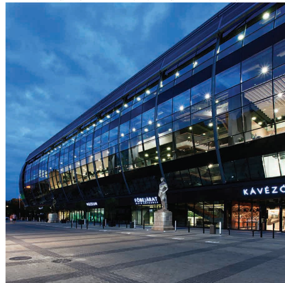
A külön ide kifejlesztett, egyedi világítási rendszer révén az épület éjszakai megjelenése is élményszámba megy.
