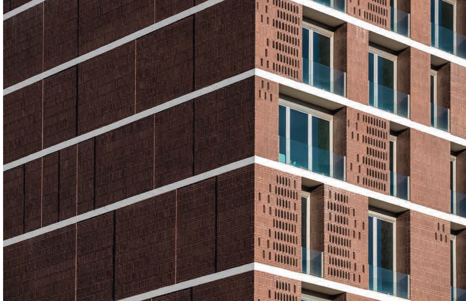
Szellőzőnyílások a téglahomlokzaton
