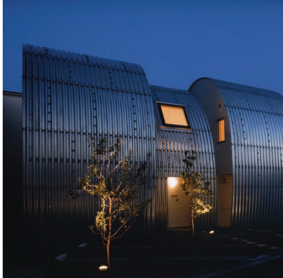
Roofecture Mfs : különböző méretű, alagutaknál használatos, íves hullámlemezekből épült ház
