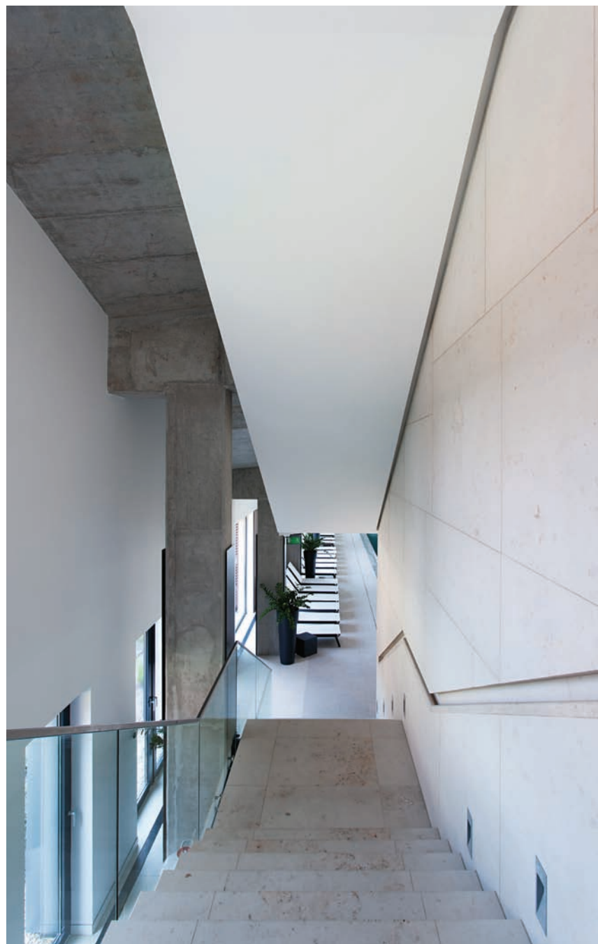
Az emeletre vezető lépcsőtér. Láthatóvá tett betonvázás szerkezet és ammoniteszek nyomai a kőburkolatban
