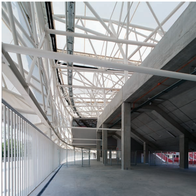
A tartó- és vasbeton-szerkezetek kivitelezési minősége a lehető legmagasabb szintű
