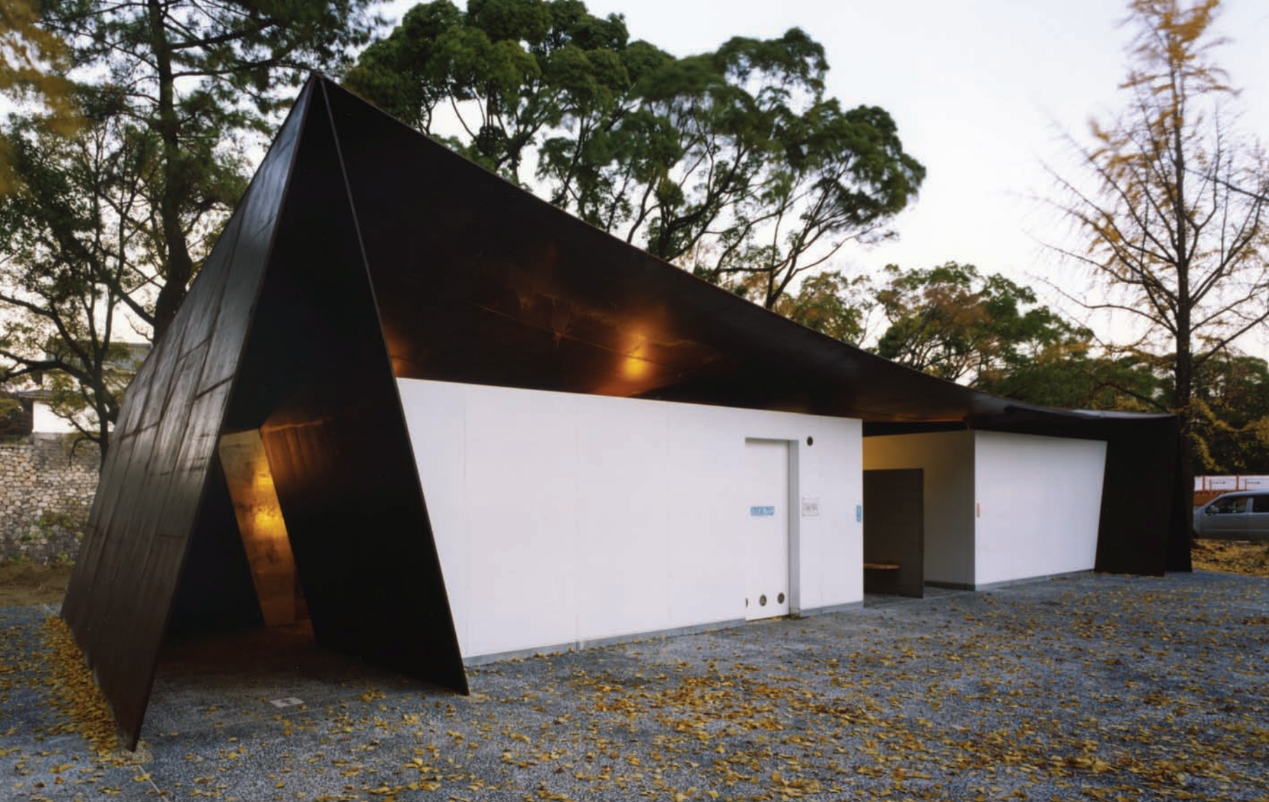
Roofecture HH: üvegszál-erősítésű áttetsző tető, egyenletes nappali fény, szél a közlekedő terekben. A japán toloajtók selyempapírja hasonló fényhatást eredményez
