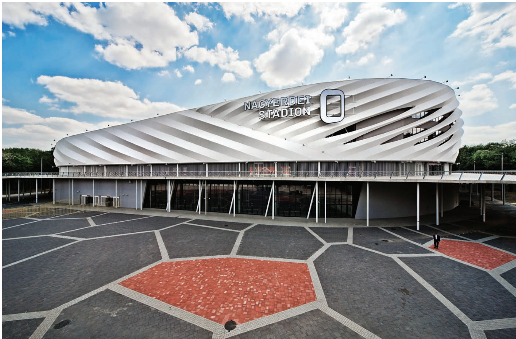
A megemelt közlekedő rámpák ívei között különféle teresedések alakulnak ki. A képen a rendezvénytér, amelyhez a földszinten fedett rendezvényhelyiség csatlakozik
