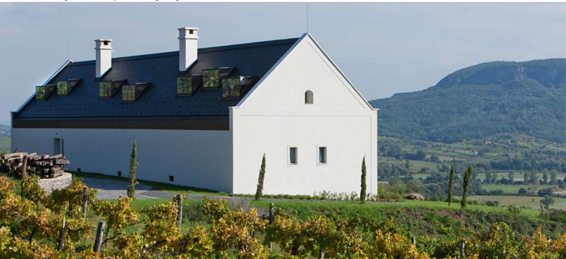
Minden oldalán üvegből, keret nélkül épültek a tetővilágító üvegszemei az északi oldalon
