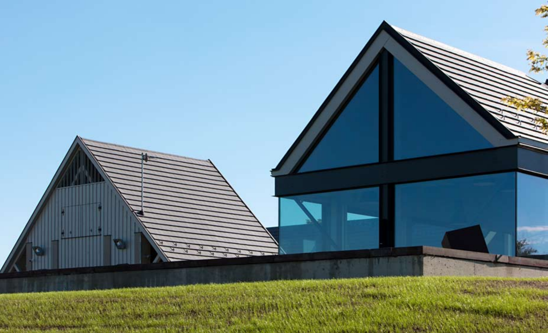
Minden épületrész a szürke deszkás régi présház geometriáját vette át. Előtérben a rendezvényterem üvegezett véghomlokzata látszik
