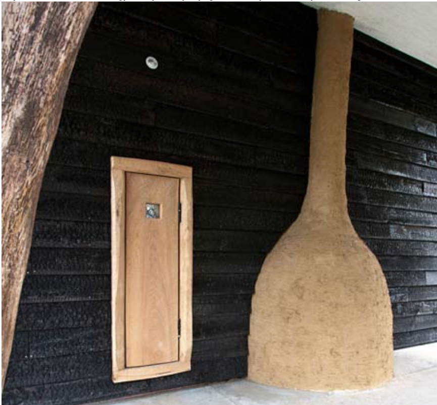
Bejárat és kandallóhát – hagyományos alapanyagokból és eljárásokkal építették meg a Storkhouse-t
