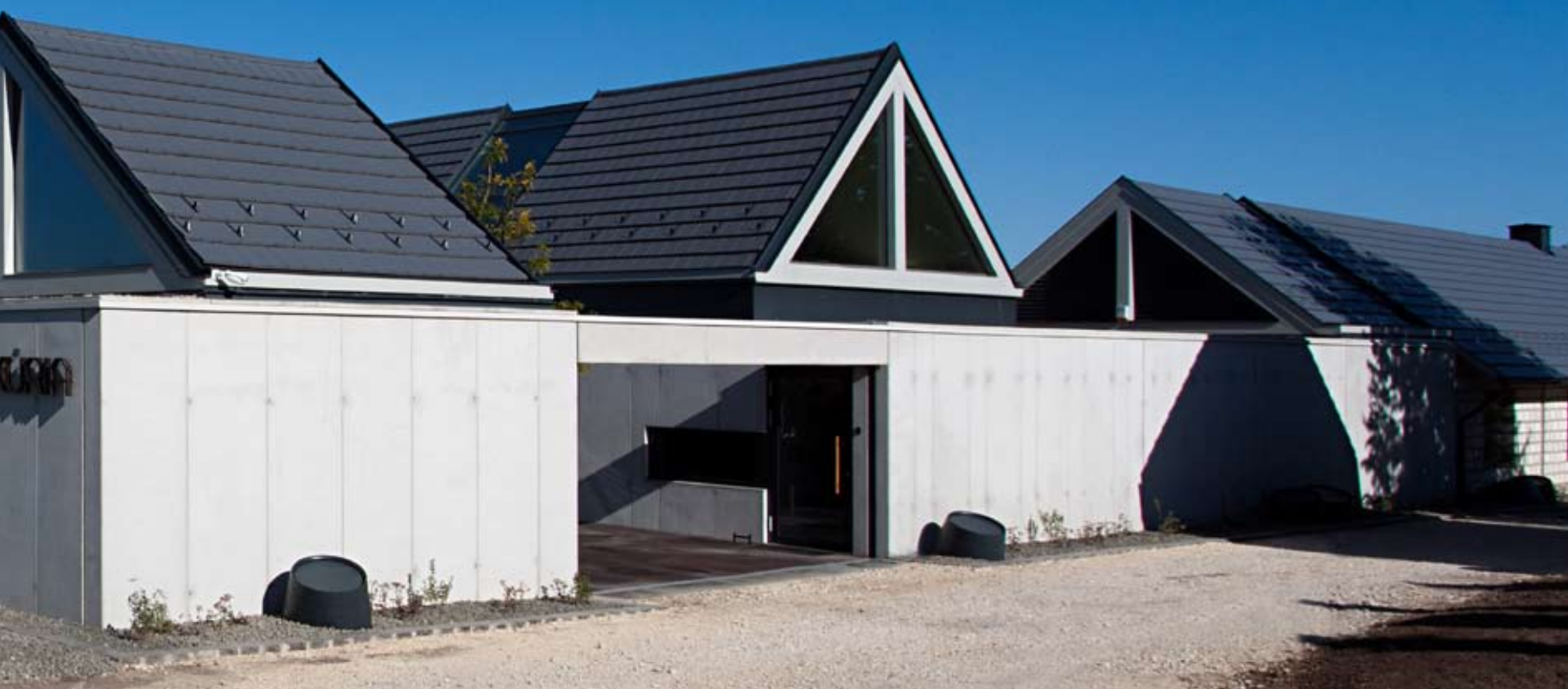
A dülőlút felől ez a látvány fogadja az borászathoz érkező látogatót. Balra a vinotéka, középen a rendezvénytér teteje, aminek padlasterében iroda kapott helyet. A jobb szélén a palackozó tetőzete látszik
