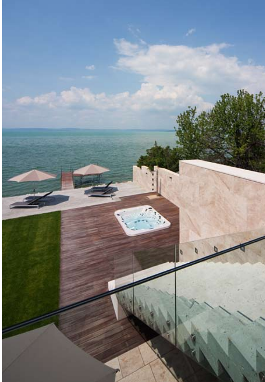
A környezettudatos technológiákkal és anyagokkal megépített épület üvegkorlátokat kapott, ami a Brückl Kft. munkáját dicséri
