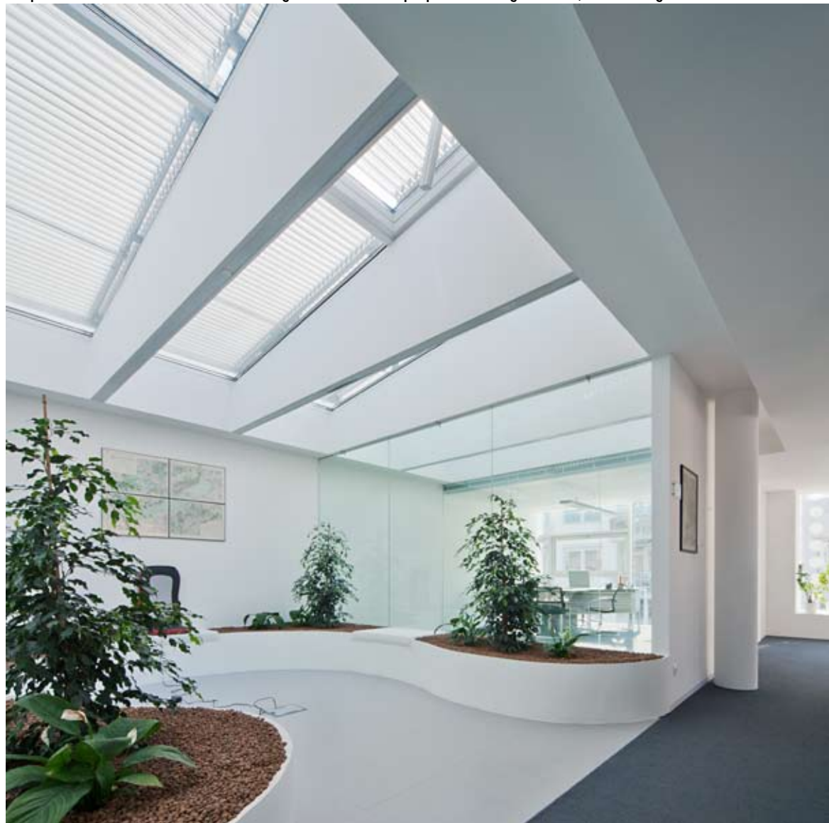
Az épület átszellőztetésében és természetes világításában kulcsszerepet játszó felülvilágító-hasíték, illetve intelligens vezérlésű tetőablakok
