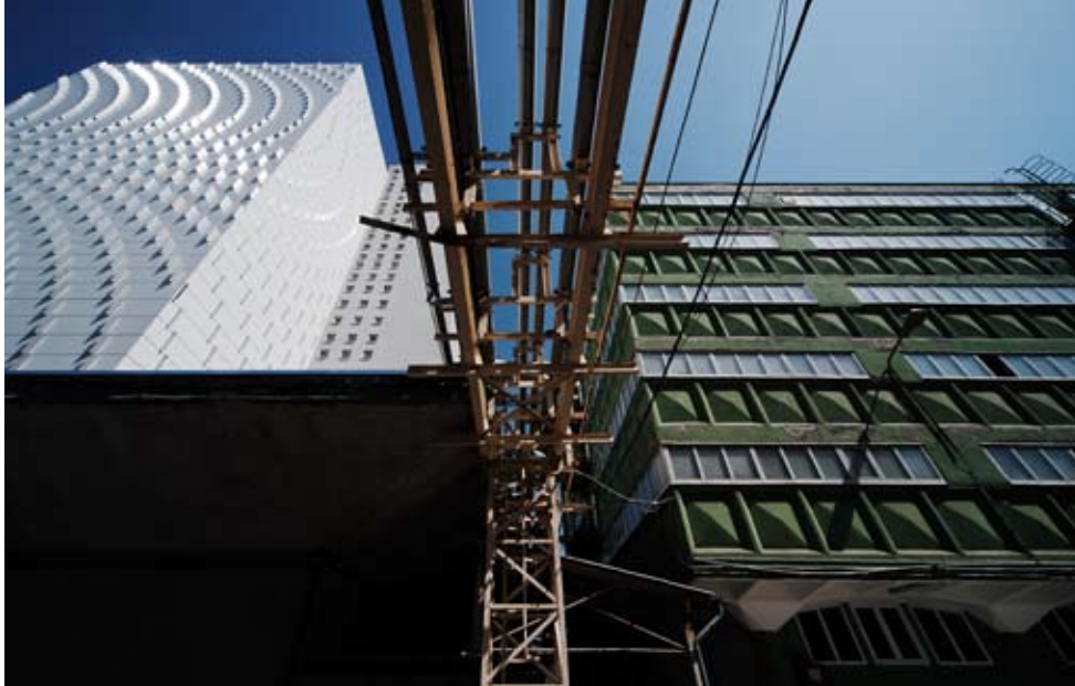
Érdekes dialógust folytat a Juhász-Garay-féle épület gyémántmetszés betonpanellel burkolt homlokzata és az új raktárépület
