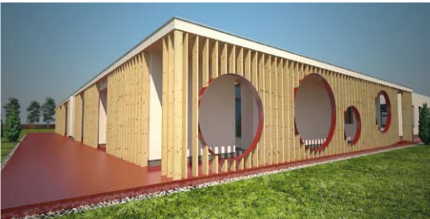
Az eredeti komor épületszerkezetek megtartása mellett élénk színek keltenek barátságos hangulatot a 70-es években épült bölcsőde felújított tömegében
