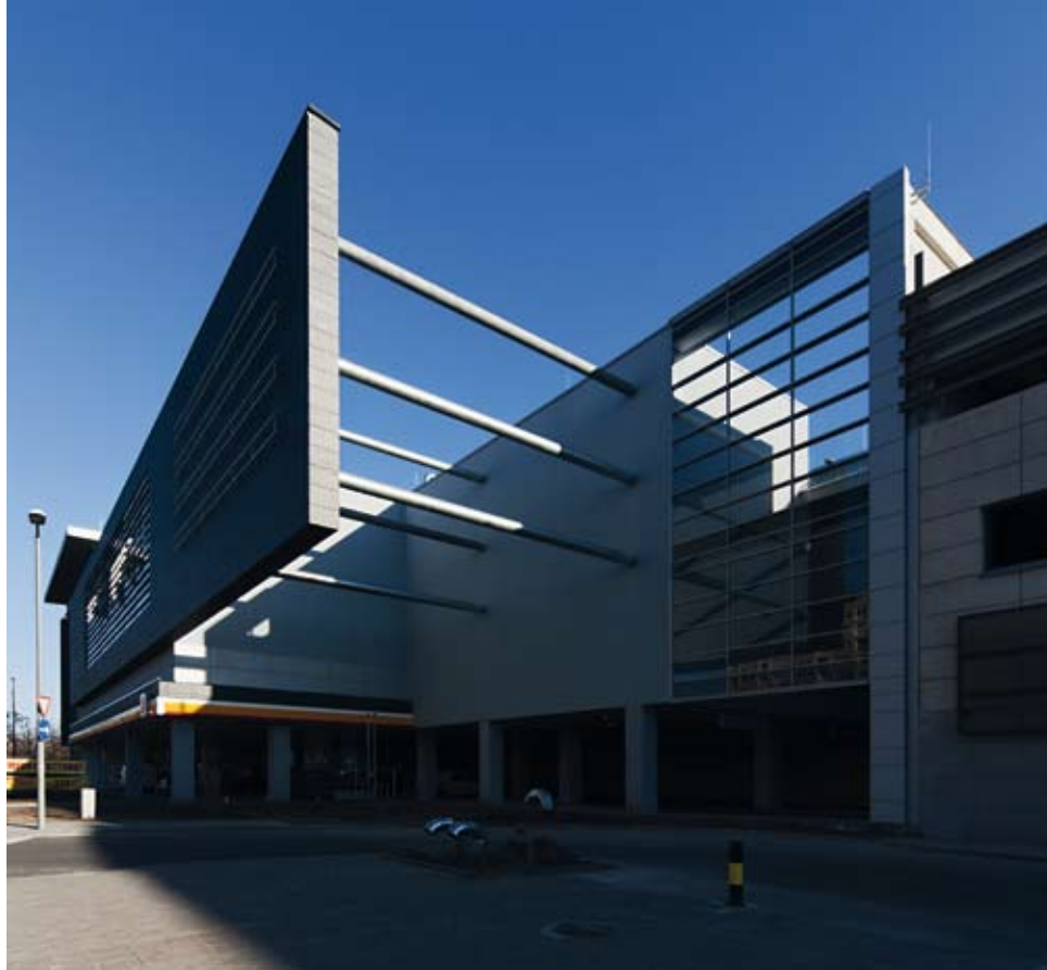
Az új épület zárt térfalat hoz létre úgy, hogy a régi épület parkolójának rámpáját, illetve gazdasági bejáratait takaró falszakasz síkjába illeszkedik
