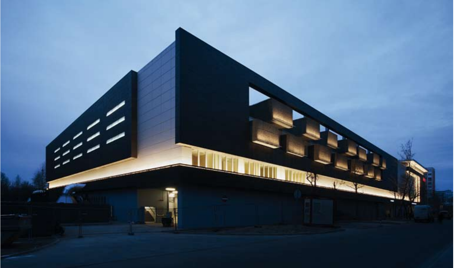
Egymást átmetsző homlokzati síkok, áttörtség, burkolati anyagváltások, és az épület éjszakai megvilágítása is hozzájárul a tömb dinamikus megjelenéséhez
