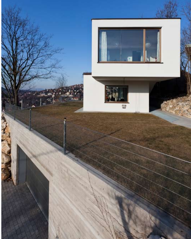
Rakott kő és látszó beton támasztékokkal érkezik a meredek útra faragott kocsibeálló az angolaknával szellőztetett garázshoz
