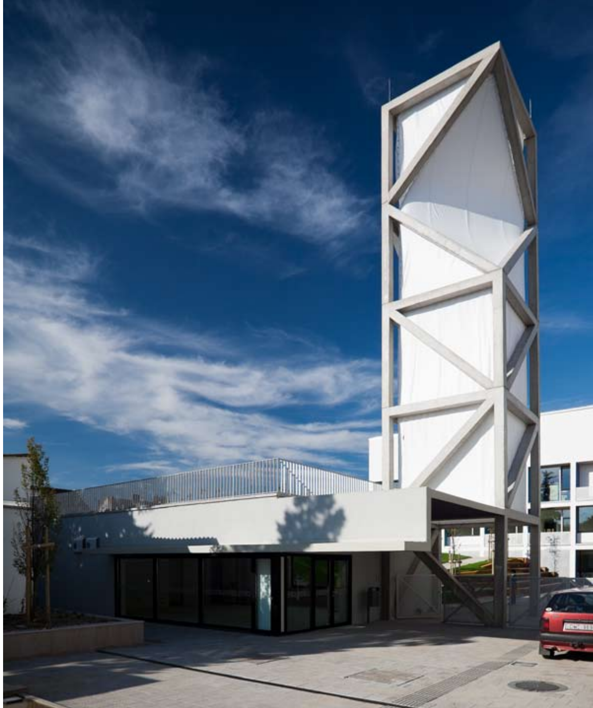
A klímatorony felhívja a figyelmet az új funkció bátor tömbbelsőbe feszülésére, és egyben kellemes mikroklímát alakítva jelképezi a környezettudatos szemléletmódot
