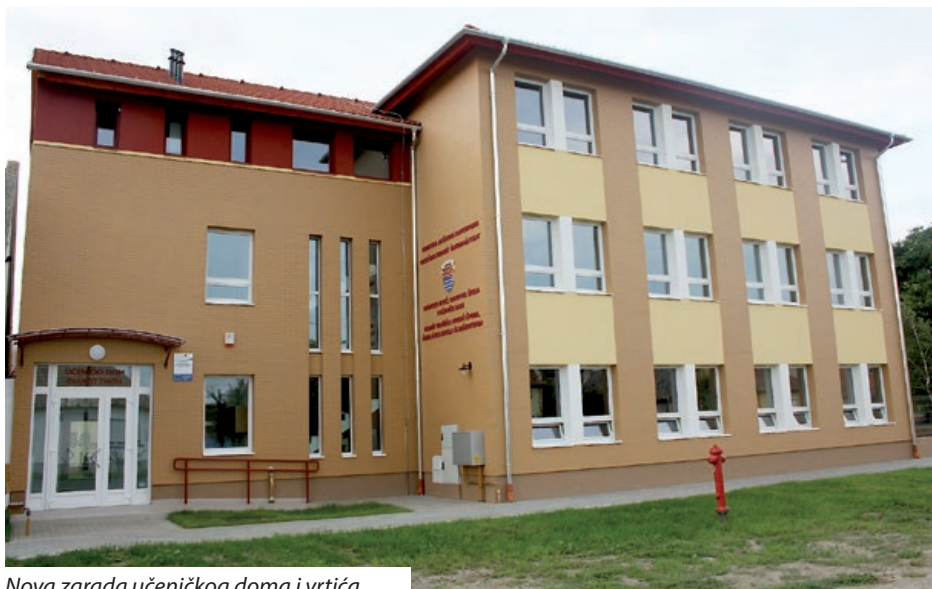
Nova zgrada učeničkog doma i vrtića
