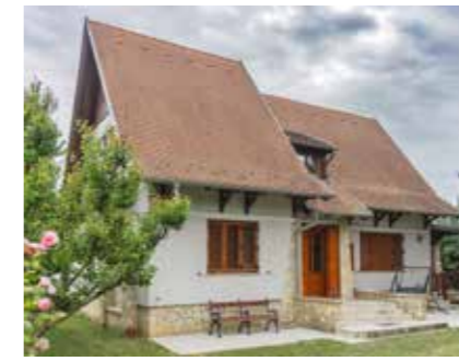
▲ Madaras-nyaralóépület, Balatonvilágos [2002]. Fotó: Szántó Tamás
