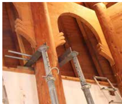
▲ Oszlop ideiglenes felfüggesztése
