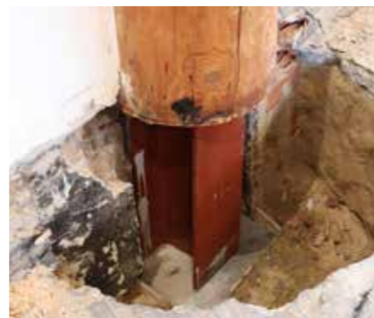
▲ Korhadt oszloprészek kiváltása
