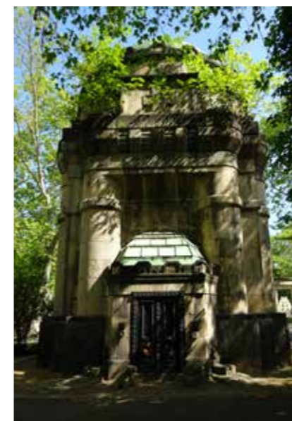
◀ Felújítás előtti állapot, Malosik-mauzóleum
