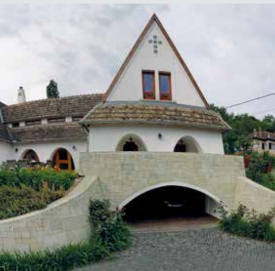
▼ Családi ház, Budafok. Építészet: Tóth Péter, Szűcs Endre, fotó: Tóth Péter
