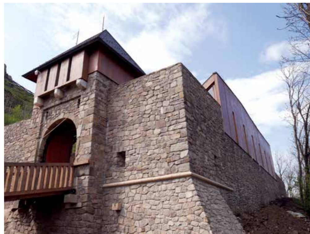
▲ Füzer, alsóvári kaputorony-rekonstrukció
