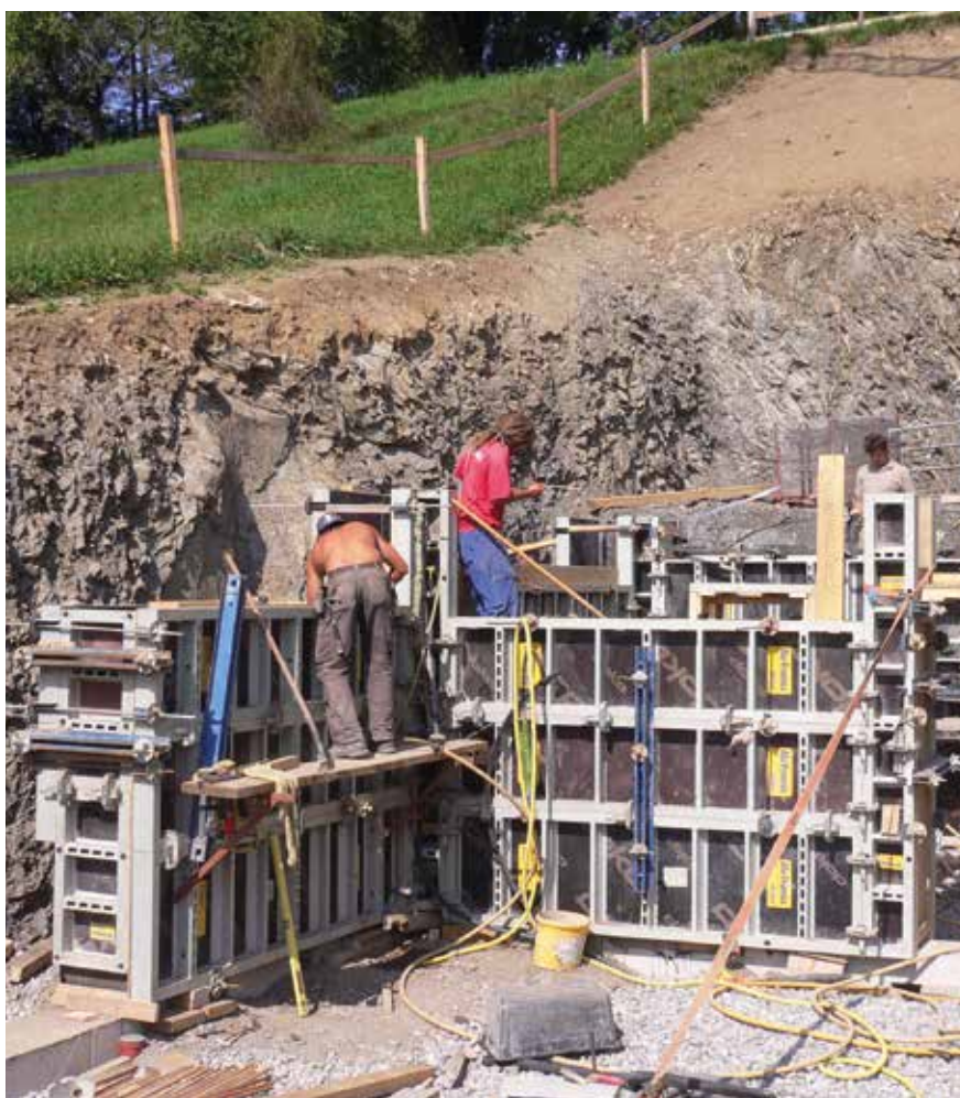
▲ ► Martin Rauch-ház építése. Schlins, Ausztria. Építész: Martin Rauch, Boltshausen Architekten AG, 2008. Fotók: Lehm Ton Erde Baukunst GmbH
