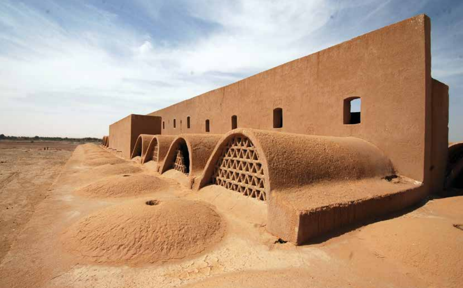
▲ A piac természetes hűtését elősegítő felépítmények (1963–67). Az épület befejezetlen maradt a hatnapos háború miatt. Új-Bárisz, Kharga-oázis
