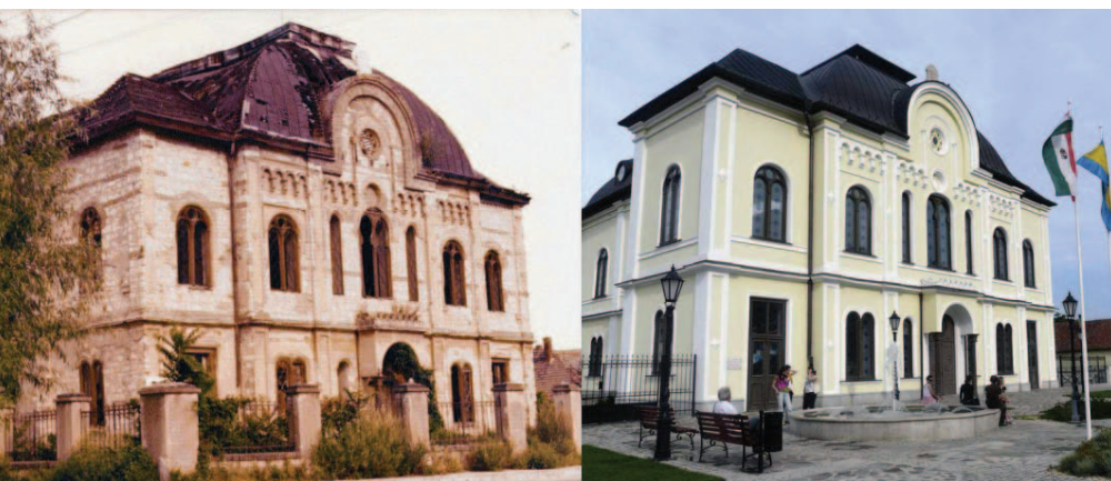
Farkas Pál: Zsinagóga helyreállítása, Tokaj 2006
