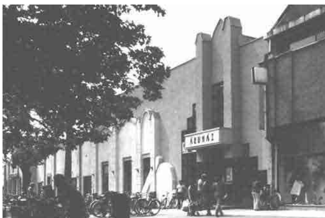
Áruház bővítés, Nagykovács, 1982
