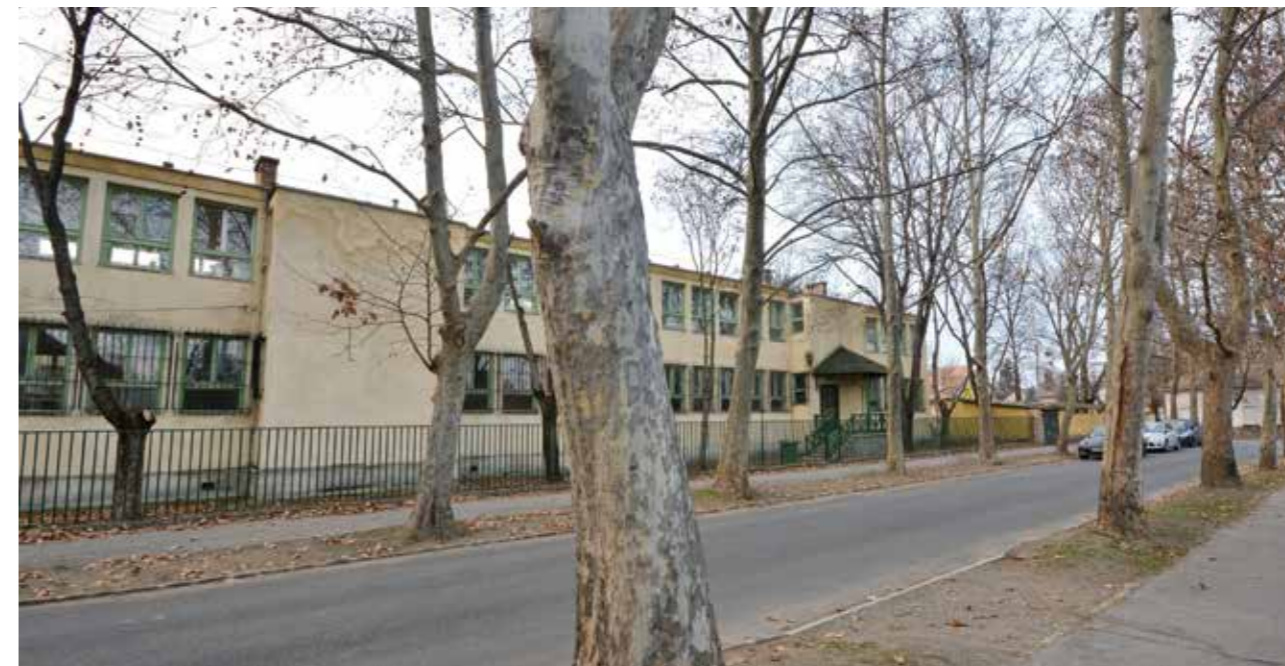
A KALÁSZI ÚTI ÉPÜLET A PLATÁNFÁKKAL
