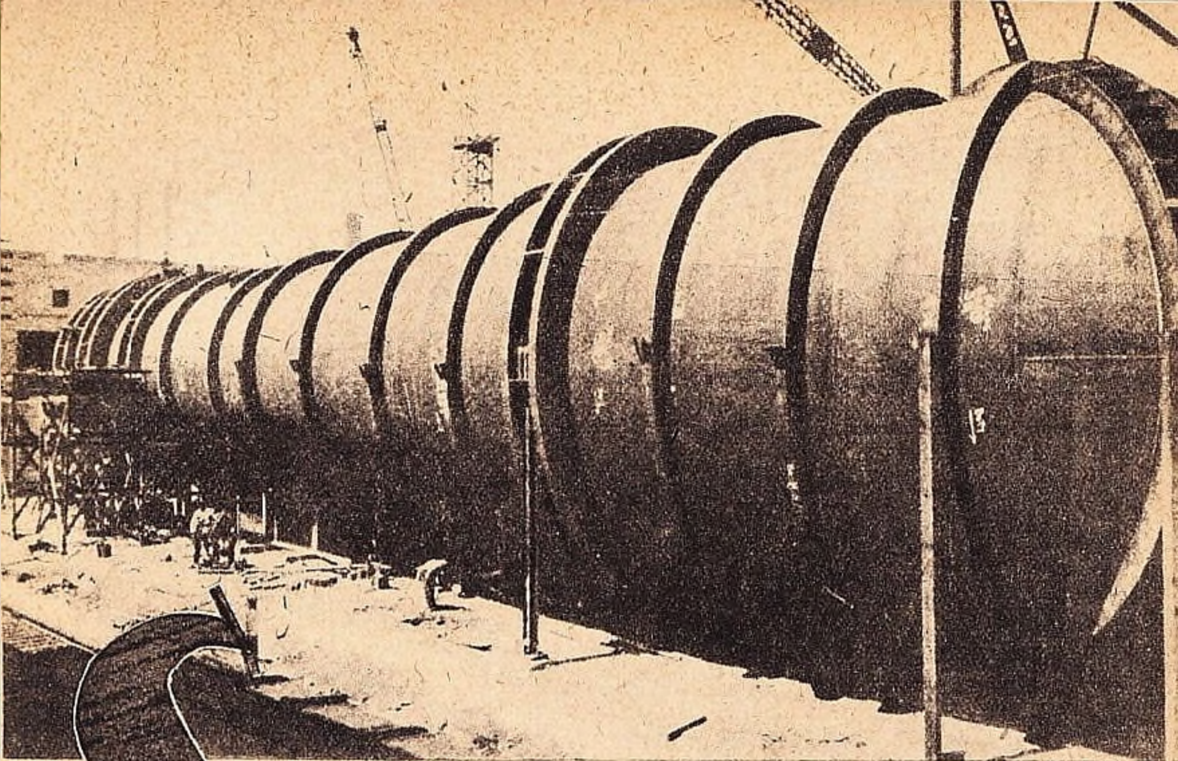
A szélesatorna építése. Az építésnél kb. 1500 tonna vasat használtak fel és kb. 32 km hosszú villamos fűtővezetést végeztek
