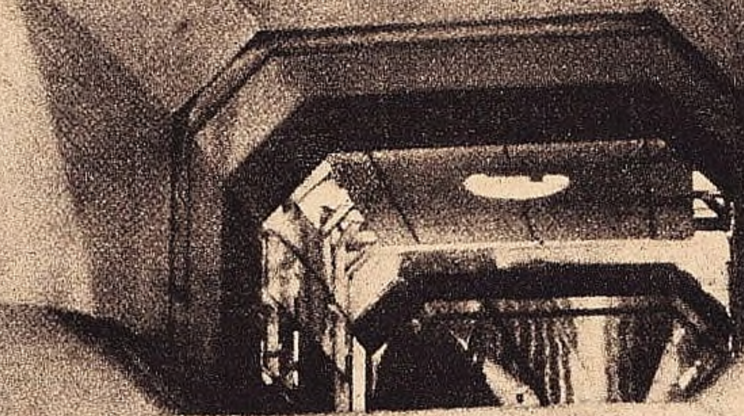
Kifűzőszáj a mérőter előtt a csatorna belsejé- ből nézve.
