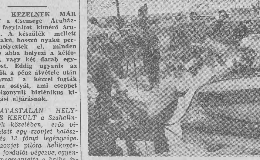
Az útépitők országjárta főként a tél okozta rongálódások kijavításán dolgoznak. A képen: Dinnyésről bontják az árvíz által kimosott és összetört betonátterest
