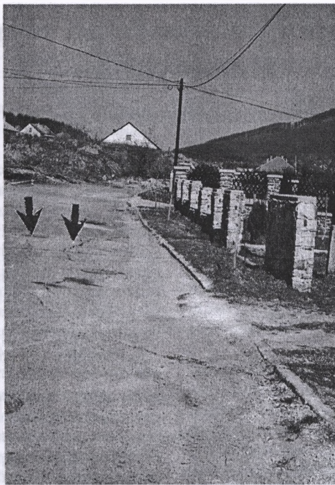
8. fotó. A József A. u.-i húzási repedés. Megfigyelhető a régebbi húzásos repedés javítása az útpályán
