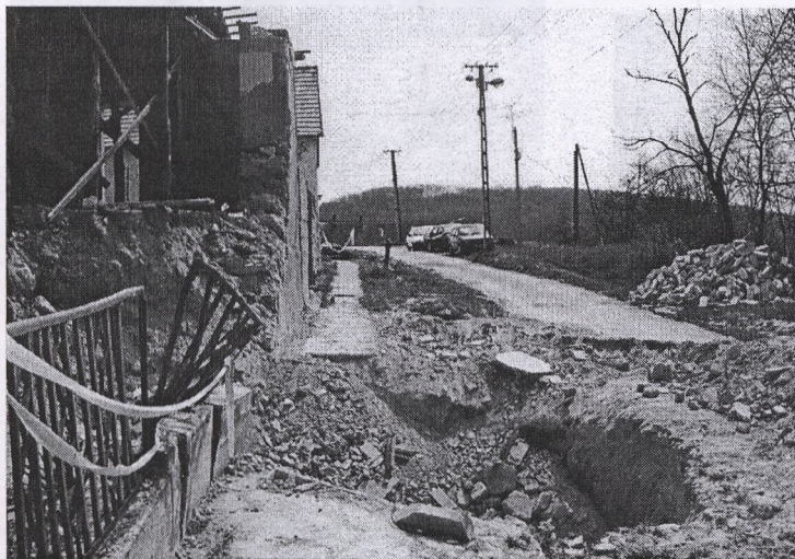
Helytelen településrendezés következtében keletkezett épület károk - Alsónána
