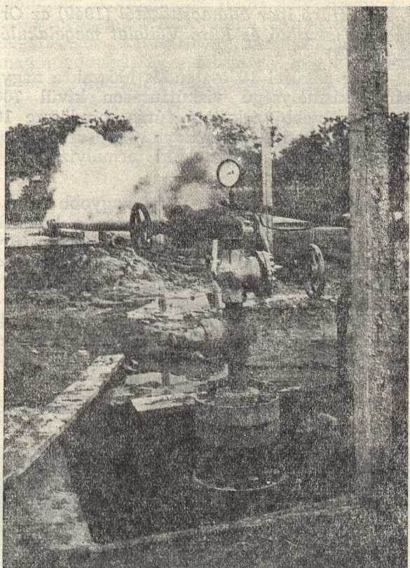
10. ábra: A nagyszénási leegyszerűsített kútfej kiképzés
