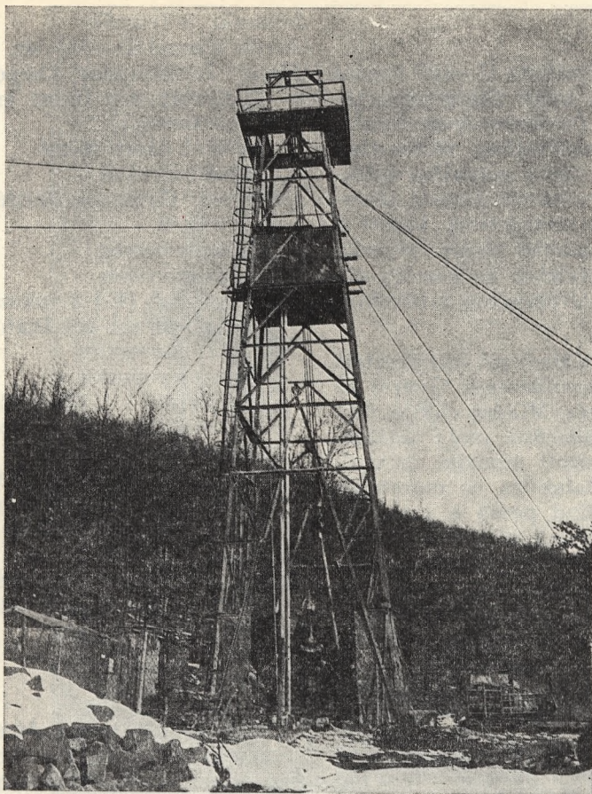
8. ábra: ZIF—1200 típusú fűrőberendezés, K—30 típusú fűrőtoronnyal
